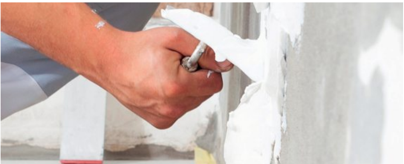
Aplicación de base coat sobre el sustrato de fachada.
